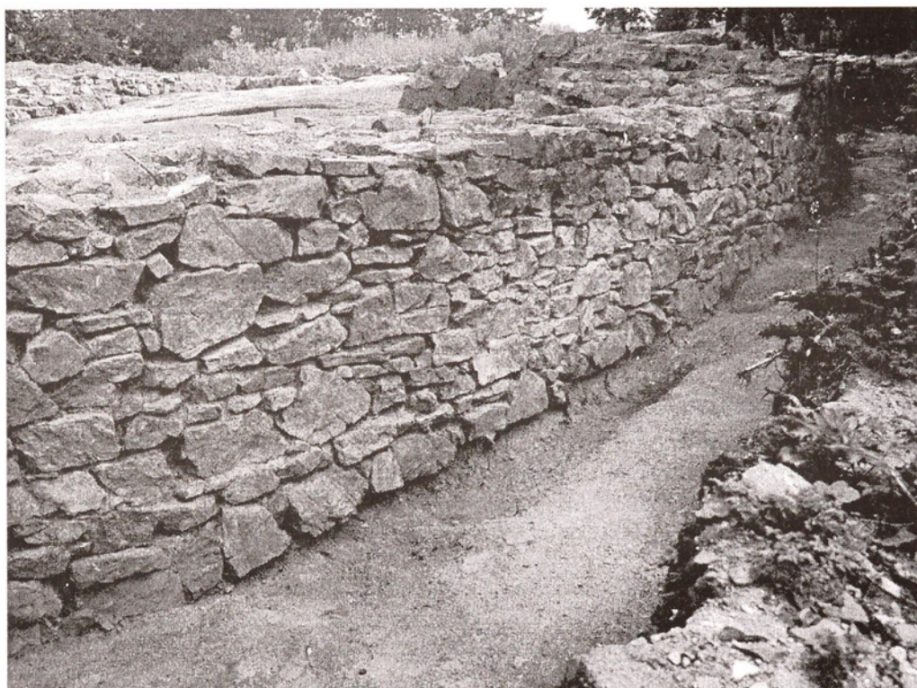
Obr. 2. Lelekovice- Hrad. Vnější líc hradby na jihovýchodní straně.
