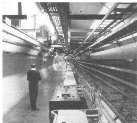
Pohled na část největšího kruhového urychlovače na světě LEP - Large Electron Positron Collider, dokončeného r. 1989. Vlevo nahoře traverza pro lanovku na dopravu osob uvnitř tunelu.
