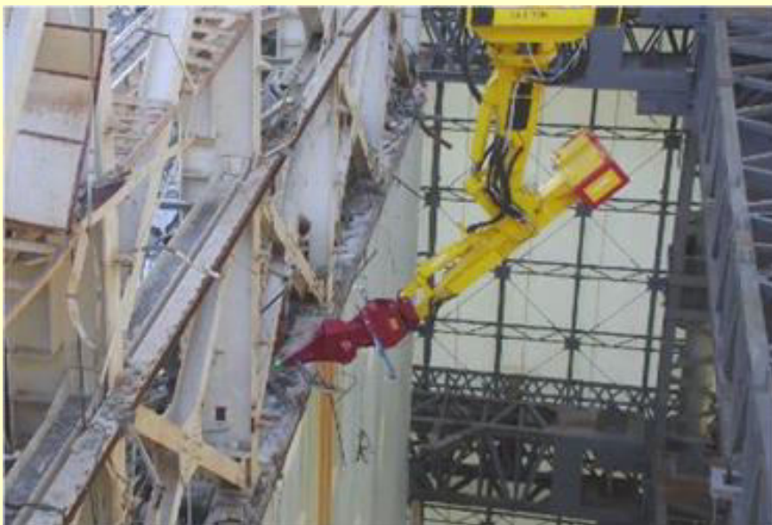
Demolice zničené horní části 1. bloku
