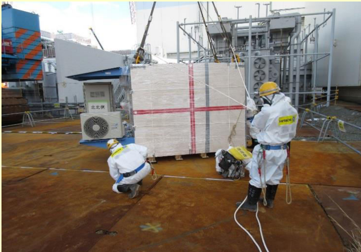
Umístování detektorů mionů u prvního bloku
