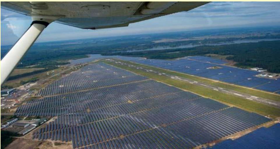
Německá sluneční elektrárna Neuhardenber má 148 MW
